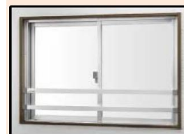
転落防止の手すりの設置
